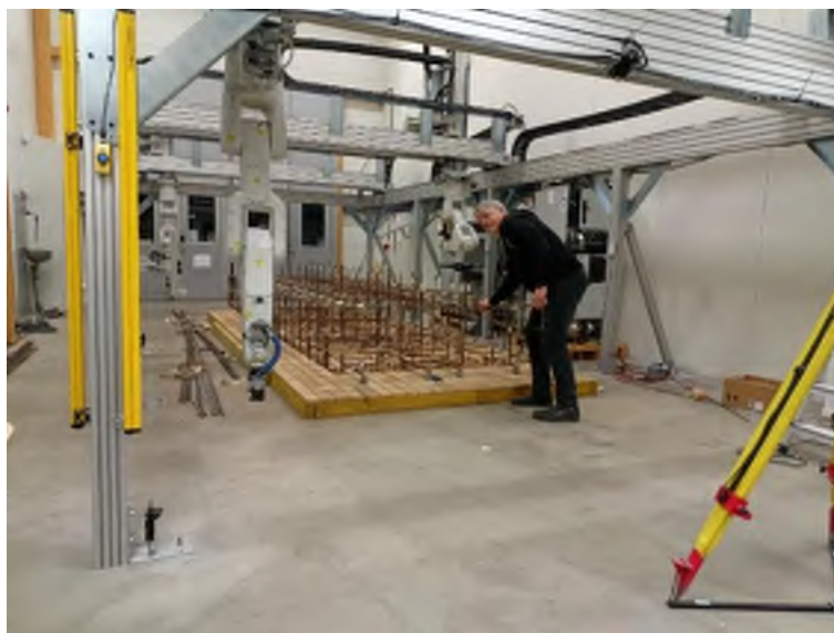
Figur 19. Korg nr 1 färdigbyggd med hjälp av armeringsstationen. Ingemar Reyier konstaterar att korgen är stabil.
