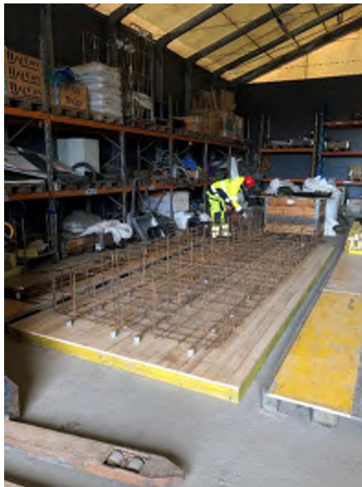
Figur 11. Korg nr 1 byggdes manuellt på Skanskas arbetsplats i Kungens kurva. Den färdiga korgen transporterades sedan till laboratoriet i Västerås. Fotot visar hur de sista järnen najas fast av Abubakar Kathry, projektingenjör på Skanska.
