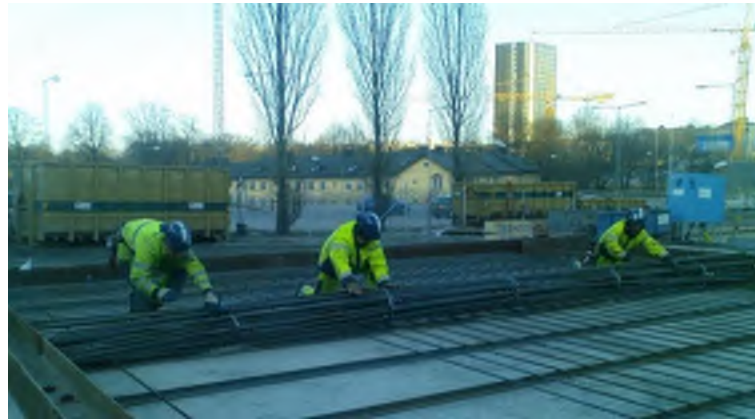
Figur 1. Stora armeringsenheter/korgar prefabriceras för en betongtunnel i Norra Länken-projektet utanför Stockholm. Korgarna tillverkades på en mallplan. De färdiga enheterna lyftes därefter in i formarna.
