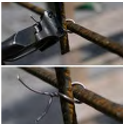
Figur 8. Najningspunkter vid en armeringskorg (Spiksäkert, 2010)
