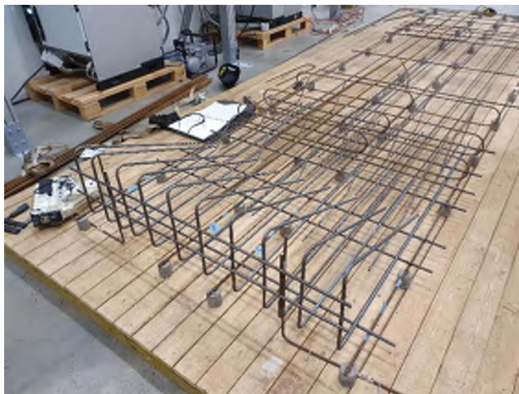
Figur 14. Foto från det manuella byggandet av korg nr 2.
